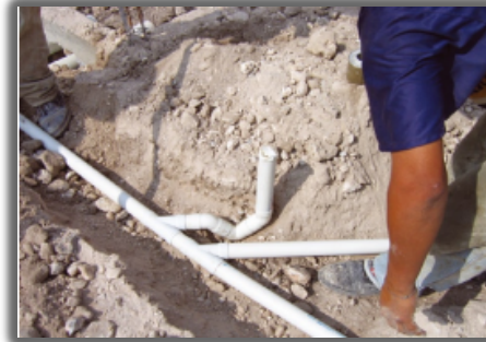
FOTO No.7. Ejemplo de instalación de tuberías
