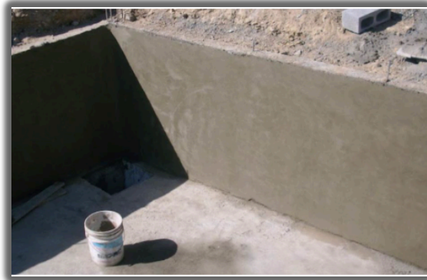
FOTO No.9. Ejemplo de impermeabilización de paredes de tanque subterráneo
