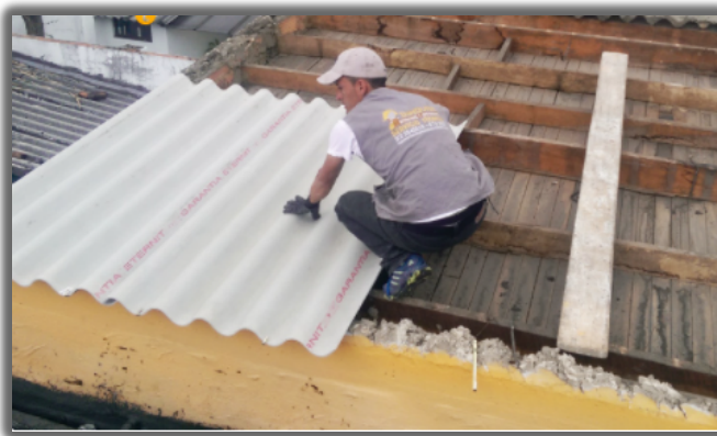
FOTO No.22. Ejemplo de instalación de teja.
