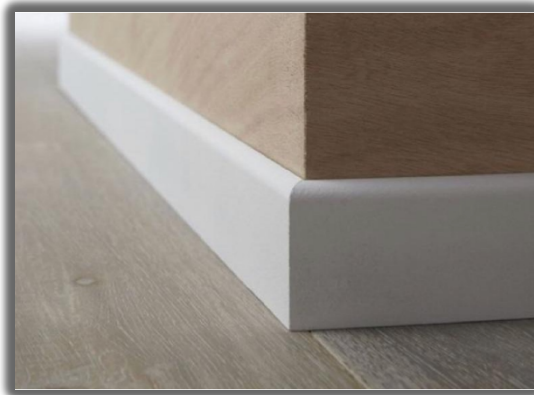
FOTO No.21. ejemplo de guardaescobas totalmente instaladas.
