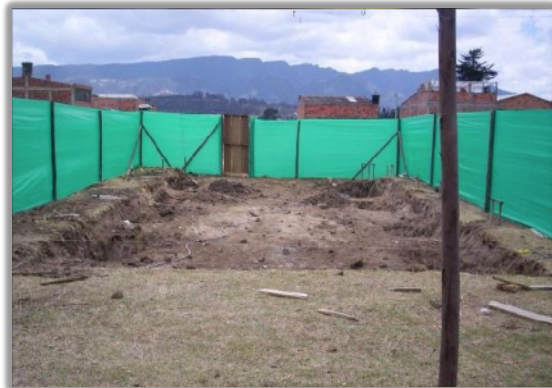
FOTO No.2. Ejemplo de limpieza y retiro de Escombros del lote
