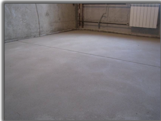
FOTO No.17. ejemplo de piso totalmente nivelado.
