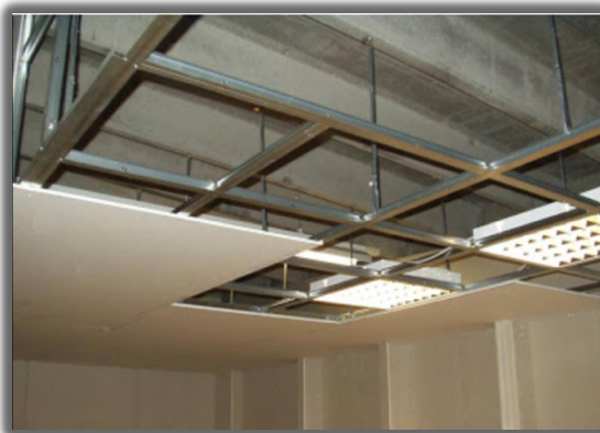
FOTO No.31. Ejemplo de instalación de estructura de cielo raso.
