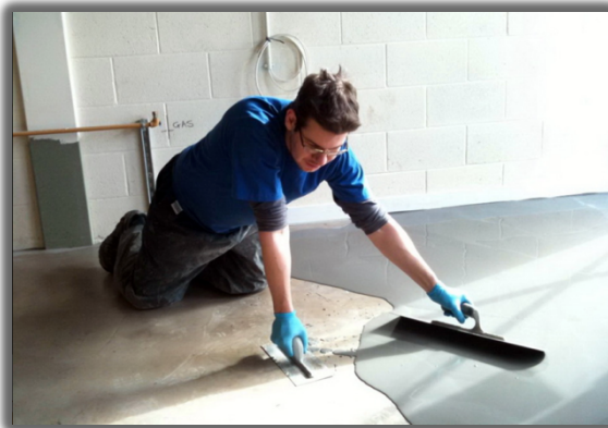
FOTO No.16. ejemplo de aplicación de mortero para nivelación de piso.
