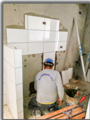
FOTO No.26. instalación de enchape cerámico.
