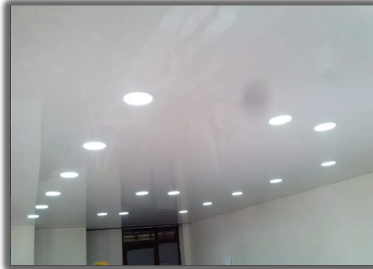
FOTO No.34. Ejemplo de cielo raso terminado.
