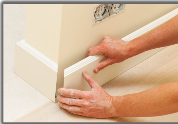
FOTO No.20. ejemplo de instalación de guardaescobas.
