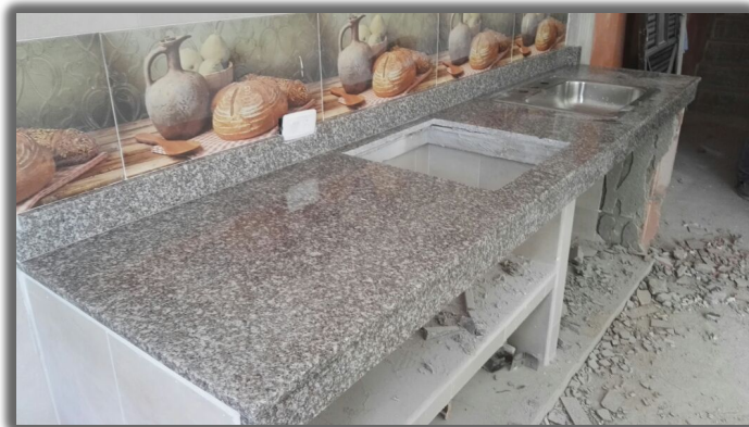
FOTO No.27. Ejemplo de enchape en granito pulido en mesón lavamanos.
