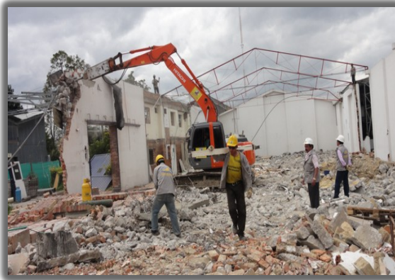
FOTO No.1. Ejemplo de demolición
