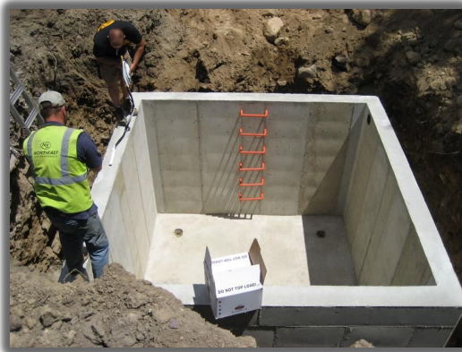
FOTO No.8. Ejemplo de tanque subterráneo
