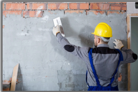
FOTO No.15. Ejemplo de pañete en muro de mampostería
